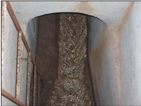
La captación consiste en una galería que discurre paralela al arroyo a menos de un metro de profundidad y desagua en un registro en la margen derecha. Tiene un caudal medio de 20 l/s variable entre 6 y 40 l/s.
