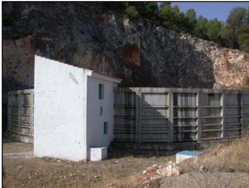
trata de un depósito de planta circular fabricado en hormigón. Su capacidad de almacenamiento es de 700 m<sup>3</sup>. Se abastece desde los sondeos Los Pinos y La Cantera (Pinos 2).
