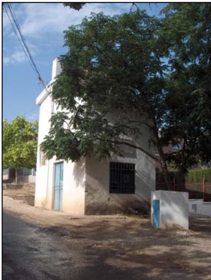
Su caudal de explotación es de aproximadamente 8 l/s. El nivel estático en el sondeo próximo Barrena II (en la arqueta de la fotografía) se situaba a 139,40 m de profundidad el día 30 de octubre de 2006, a cota aproximada de 678 m s.n.m.. Suministra un caudal de 8 l/s aunque en 2005 no se utilizó (según datos de volúmenes extraídos facilitados por la Diputación Provincial de Jaén).
