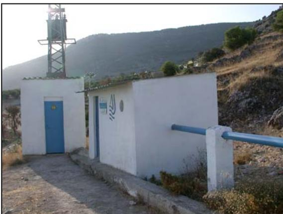
Su caudal de explotación es de aproximadamente 7,5 l/s. El nivel dinámico se situaba proximo a los 295 m de profundidad el día 4 de septiembre de 2006, a cota aproximada de 520 m s.n.m.. Está instalado con una electrobomba sumergible. La tubería de impulsión es metálica.
